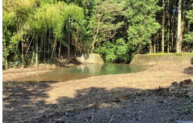
砂防堰堤の状況
