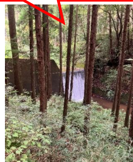
田場沢川の砂防堰堤
