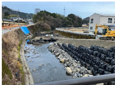
工事が進められている千福地先 佐野川と市道1-5 号線 令和6年1月3日 千福寿橋から撮影
