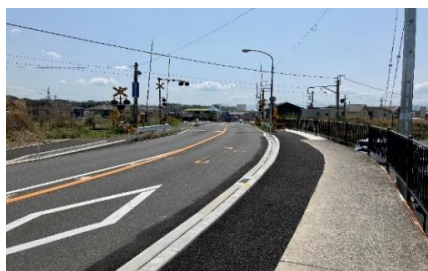
平松踏切(裾野警察署付近)
